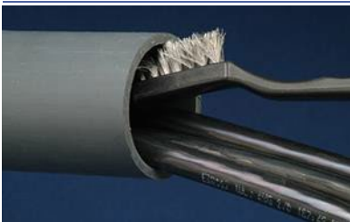
Rohr mit einer Drahtbürste reinigen, mit Lösungsmittel abwischen
