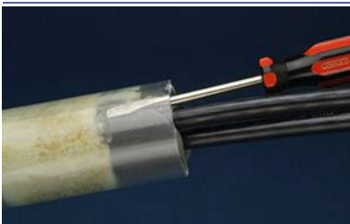
Mit Schraubendreher auf Hohlräume überprüfen
