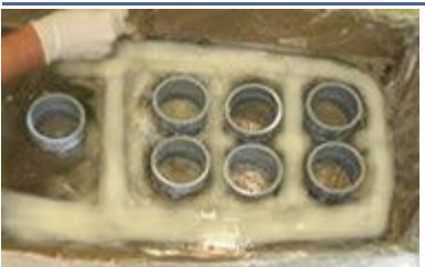
PedFloor mit einem Rührstab verteilen
