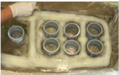
Étaler InstaGrout à l'aide d'un bâton
