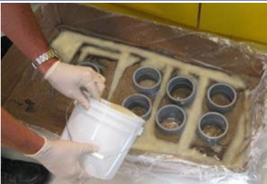
Langsam in den vorgesehenen Bereich gießen
