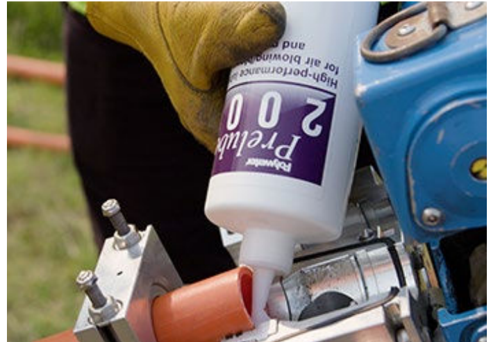
Prelube 2000 applicato al condotto prima di soffiare il cavo in fibra
