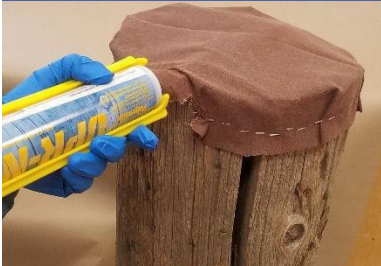
Injecter l'UPR-NF au sommet du poteau. Déplacer l'extrémité du mélangeur statique lors de l'injection.
