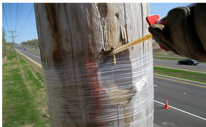
Zum Aufbringen des Mastreparatursystems von Polywater UPR NF müssen keine zusätzlichen Löcher in den Mast gebohrt werden.
