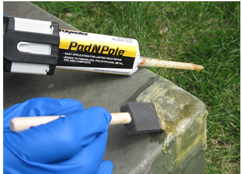
*Polywater Pad N Pole dient zur Reparatur beschädigter Gehäuse.*
