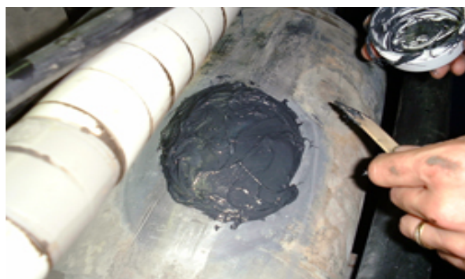
Le système de colmatage des fuites AirRepair scelle les fuites d'air dans les câbles et les épissures sous pression.
