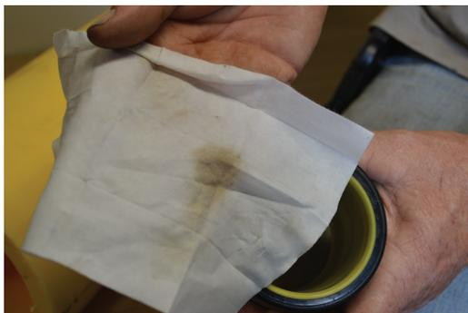
Elimina eficazmente los contaminantes antes de la electrofusión.
