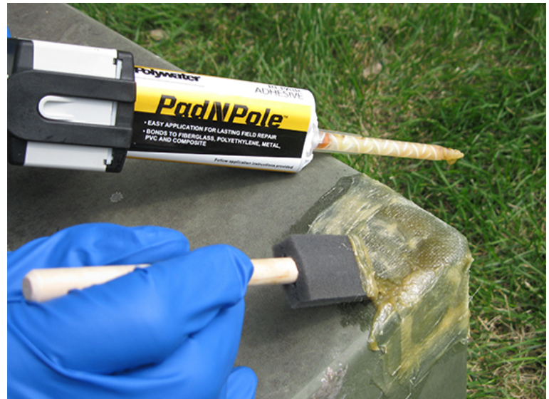
Polywater Pad N Pole dient zur Reparatur beschädigter Gehäuse.
