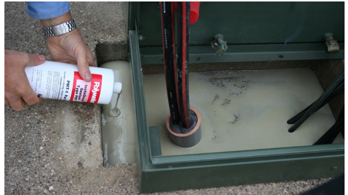
InstaGrout repariert und erzeugt eine Sperrschicht für Schranksockel.
