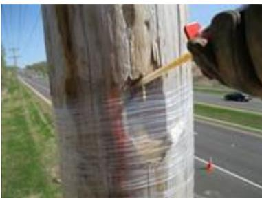
Inserire il miscelatore statico e iniettare rapidamente il materiale nel foro
