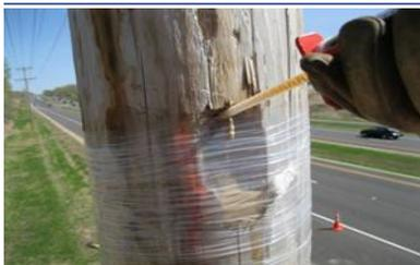
Inserire il miscelatore statico e iniettare rapidamente il materiale nel foro
