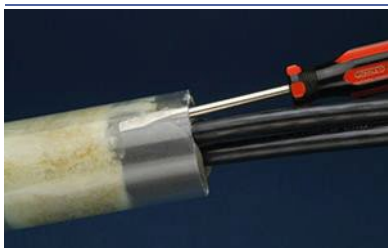
Utilizzare un cacciavite per verificare la presenza di vuoti
