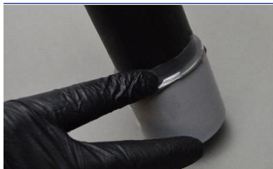
Levigatura di BonDuit su giunzione
