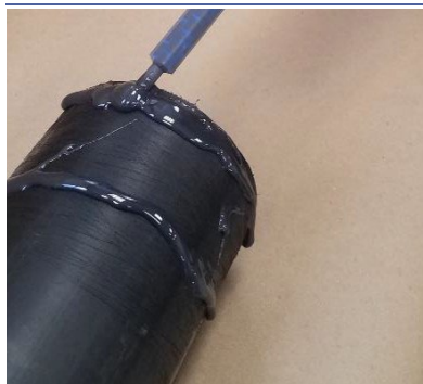
Applicare l'adesivo BonDuit
