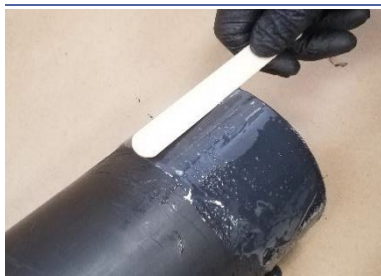
Diffusione di BonDuit sul condotto
