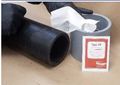
Pulire il giunto e il condotto con una salvietta detergente
