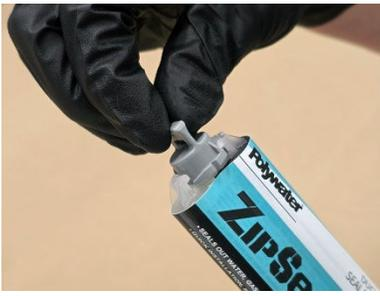
7. ZipSeal commence à s'étendre en 10 à 20 secondes. Prendre soin d'éviter le mouvement des fils et de perturber la mousse pendant l'expansion. Cela peut créer des écarts, ce qui nécessitera l'injection de mousse supplémentaire. Après injection de toutes les marques, retirer le mélangeur statique et replacer immédiatement le bouchon de la seringue.
