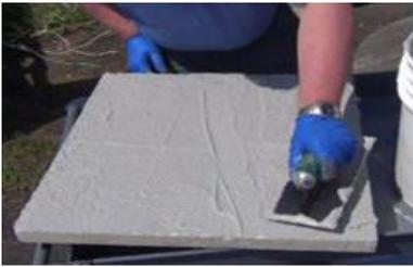
8. El tiempo de funcionamiento a 22 °C (72 °F) es de unas 2 horas. El tiempo de endurecimiento es de unas 4 horas y el tiempo de fraguado funcional es de unas 24 horas. Los tiempos de fraguado de Dura-Plate 100 dependen de la temperatura. Las temperaturas más altas acortan estos tiempos. Las temperaturas más bajas prolongan estos tiempos.
