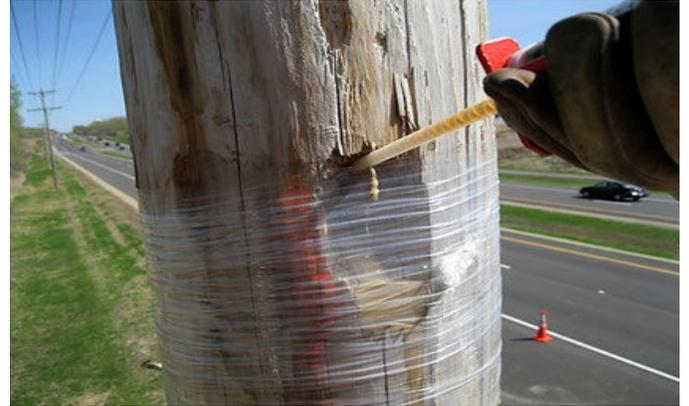
*Polywater UPR PR Pole Repair puede aplicarse sin taladrar orificios adicionales en el poste.*
