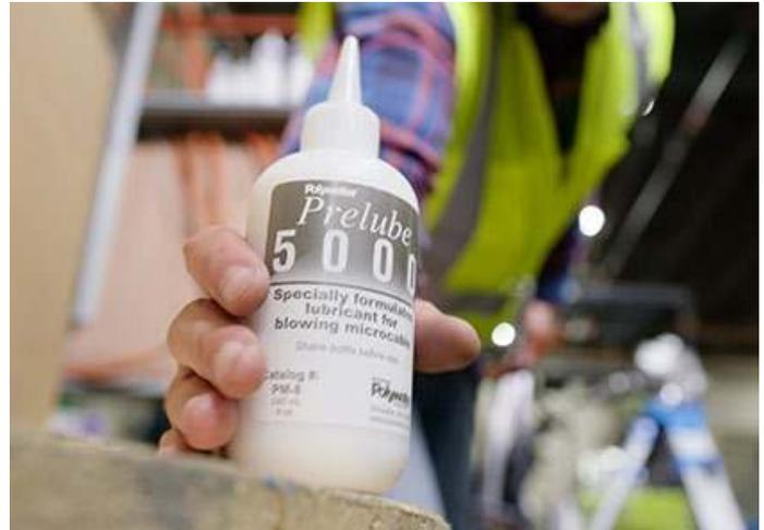
*Prelube 5000 appliqué dans un conduit avant de souffler un câble à fibre optique*
