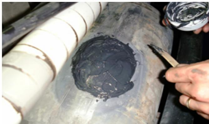
Das AirRepair-Leckreparatursystem dichtet Lecks in mit Druckluft gefüllten Kabeln und Spleißen ab.
