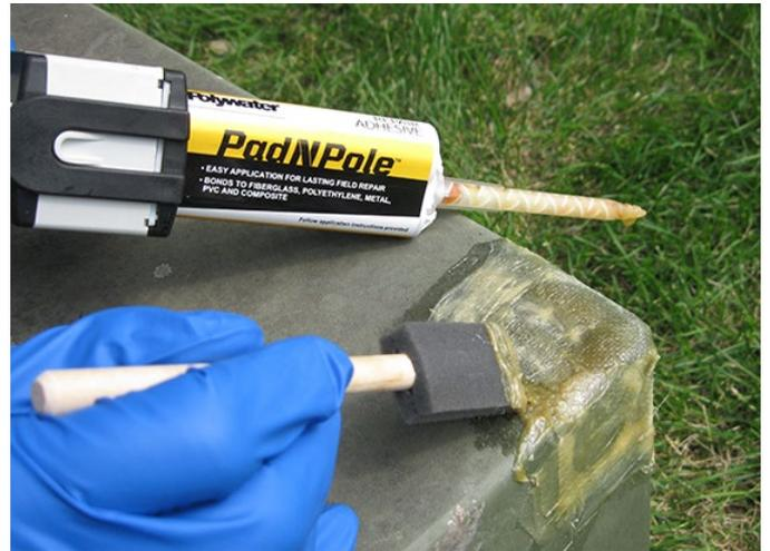
*Polywater Pad N Pole se utiliza para reparar cajas o cubiertas dañadas.*
