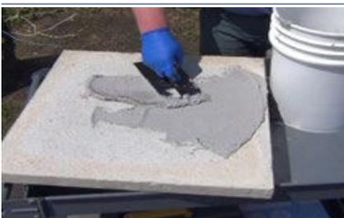
7. Appliquer une épaisseur de 3 mm à l'aide d'une truelle ou d'une spatule. Appliquer Dura-Plate 100 à température ambiante, à partir de 7 °C. Ne pas appliquer une fois que le produit a commencé à durcir.
