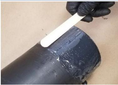
8. À l'aide d'un abaisse-langue, étaler le BonDuit XL autour du conduit de façon à ce qu'il recouvre tout le conduit, à peu près à la profondeur de
