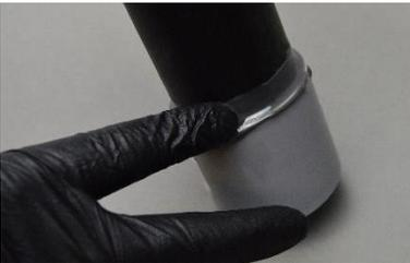
9. Presser immédiatement le raccord sur le conduit. Un maillet en caoutchouc peut être nécessaire pour s'assurer que le raccord est bien en place.
