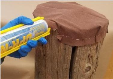
Inyecte el UPR-NF en la parte superior del poste. Mueva la punta del mezclador estático mientras inyecta.
