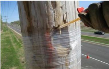
Inserte el mezclador estático e inyecte rápidamente el material en el orificio
