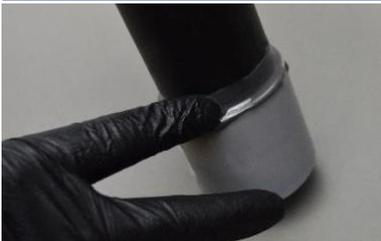
9. Empuje el acoplamiento de inmediato dentro del conducto. Es probable que se necesite un mazo de goma para asegurar que el acoplamiento se asiente completamente.
