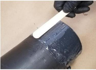
BonDuit auf dem Rohr verteilen
