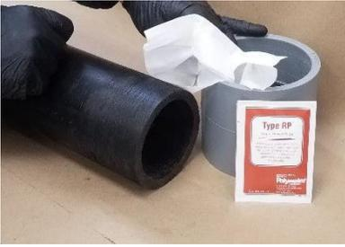
Kupplung und Rohr mit Reinigungstuch säubern
