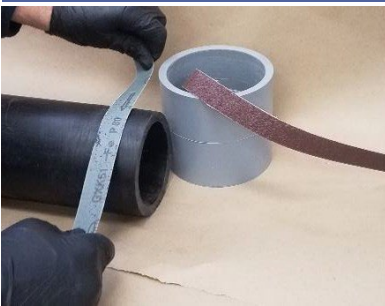
Sand conduit and coupling
