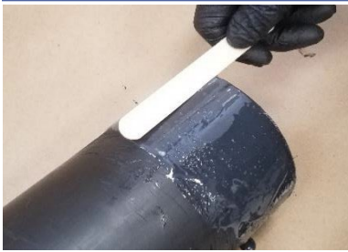
Spreading Bonduit on Conduit
