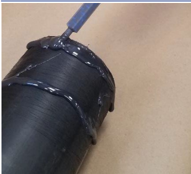
Apply BonDuit Adhesive
